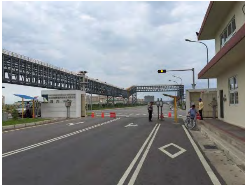
圖 9、台塑河靜鋼廠西門管制入口
